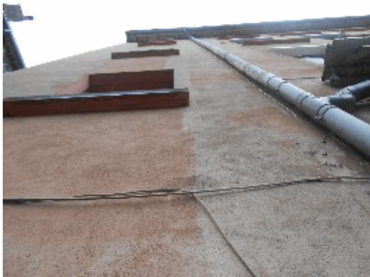
façade arrière cour
