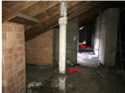
Photo n° PhA002 Localisation : 56 - 64 rue d'Alsace - Combles Ouvrage : Conduits de fluides (air, eau, autres fluides) Partie d'ouvrage : Conduits Description : Conduits Localisation sur croquis : Point002
