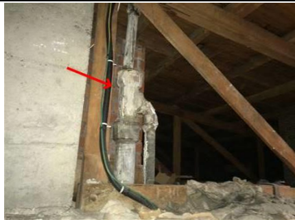
Photo n° PhA004 Localisation : 10 Anatole France - Combles Ouvrage : Conduits de fluides (air, eau, autres fluides) Partie d'ouvrage : Conduits Description : Conduits Localisation sur croquis : Point005
