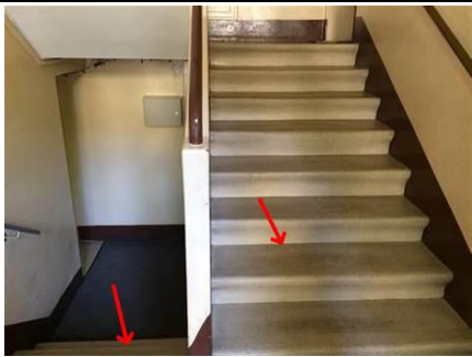
Photo n° PhA008 Localisation : 71 77 Alexandre Boutin 73 - Montée escalier Ouvrage : Planchers Partie d'ouvrage : Dalles de sol Description : Dalles de sol Localisation sur croquis : Point009
