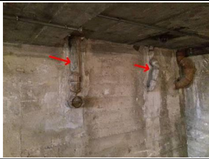
Photo n° PhA003 Localisation : 10 Anatole France - Cave parties communes Ouvrage : Conduits de fluides (air, eau, autres fluides) Partie d'ouvrage : Conduits Description : Conduits Localisation sur croquis : Point004
