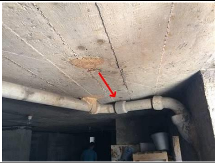
Photo n° PhA001 Localisation : 56 - 64 rue d'Alsace - Cave parties communes Ouvrage : Conduits de fluides (air, eau, autres fluides) Partie d'ouvrage : Conduits Description : Conduits Localisation sur croquis : Point001
