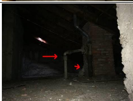
Photo n° PhA006 Localisation : 71 77 Alexandre Boutin - Combles Ouvrage : Conduits de fluides (air, eau, autres fluides) Partie d'ouvrage : Conduits Description : Conduits Localisation sur croquis : Point007
