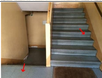
Photo n° PhA007 Localisation : 71 77 Alexandre Boutin 71 - Montée escalier, 71 77 Alexandre Boutin 75 - Montée escalier Ouvrage : Planchers Partie d'ouvrage : Dalles de sol Description : Dalles de sol Localisation sur croquis : Point008
