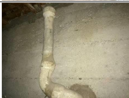
Photo n° PhA003 Localisation : 10 Anatole France - Cave parties communes Ouvrage : Conduits de fluides (air, eau, autres fluides) Partie d'ouvrage : Conduits Description : Conduits Localisation sur croquis : Point004
