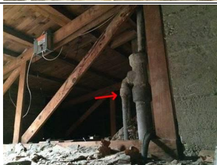
Photo n° PhA004 Localisation : 10 Anatole France - Combles Ouvrage : Conduits de fluides (air, eau, autres fluides) Partie d'ouvrage : Conduits Description : Conduits Localisation sur croquis : Point005
