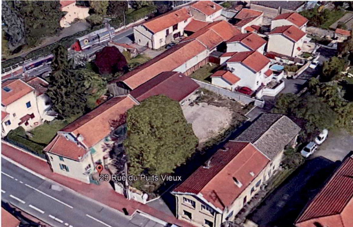
Vue aérienne google earth
